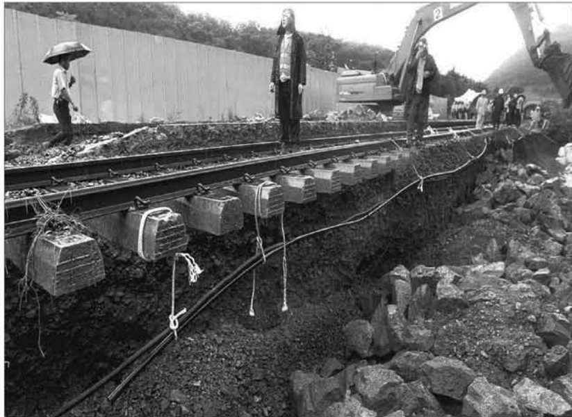
16일 호우특보가 발령된 경남지역에 많은 비가 내리면서 함안군 산인면 모곡리 경전선 철로 50m가량이 유실된 가운데 복구작업이 진행되고 있다. [별시]
